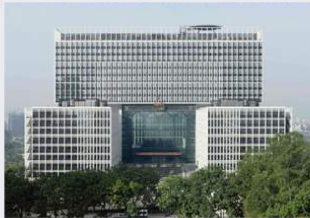
TRỤ SỞ - BỘ CÔNG AN
