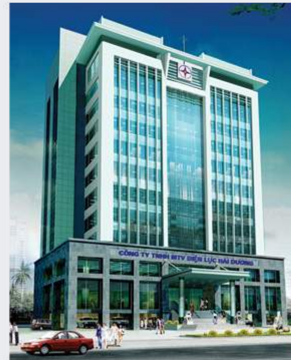
TRỤ SỞ ĐIỆN LỰC TỈNH HẢI DƯƠNG
